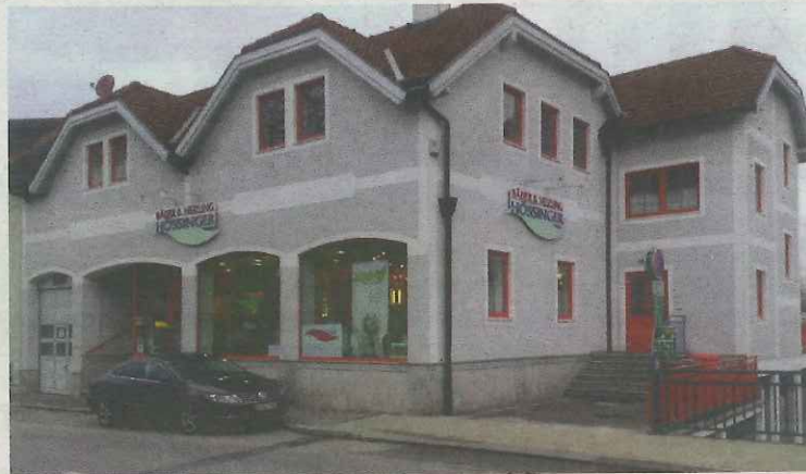
Ab Jänner 2015 übersiedelt die Firma Hössinger von der Unteren Hauptstraße in das Gewerbegebiet in Böheimkirchen. Foto: Hössinger
